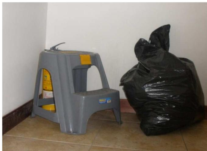
Bloqueo de extintor y disposición de residuos sólidos ERU. Sistema extinción del fuego en pisos 10 y 11. Sobreexposición a luz en la ERU.
